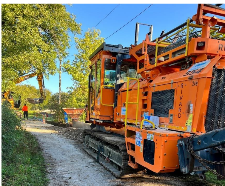
Chantier : création du réseau d'eau potable au Hameau de Voitre en 2022
